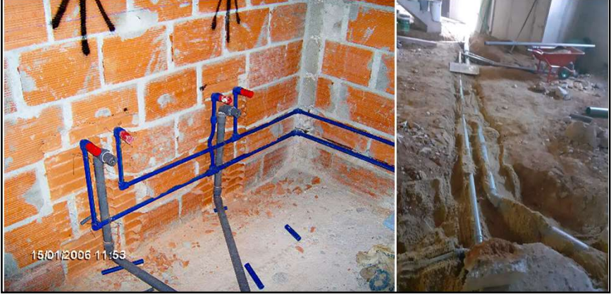
Canalizações de esgoto com tubos e acessórios de PVC
